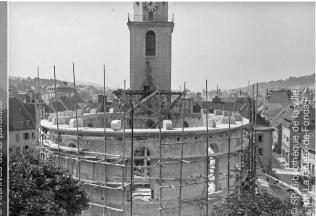
Le chantier avant la construction de la charpente métallique qui soutiendra la toiture.
